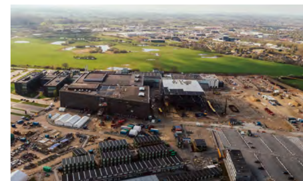
建設が進むデンマーク拠点
