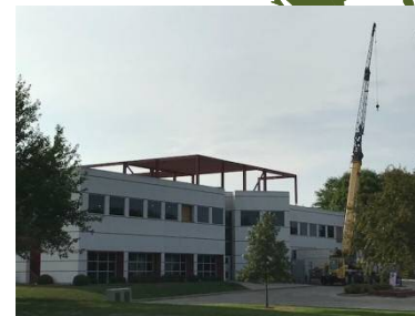
建設中のFCDI iPS細胞生産施設
